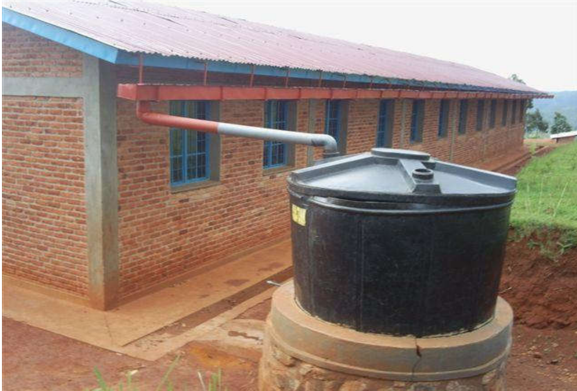
Image 2 : Système de rétention d'eau dans une école à Binguela assi dans le centre
